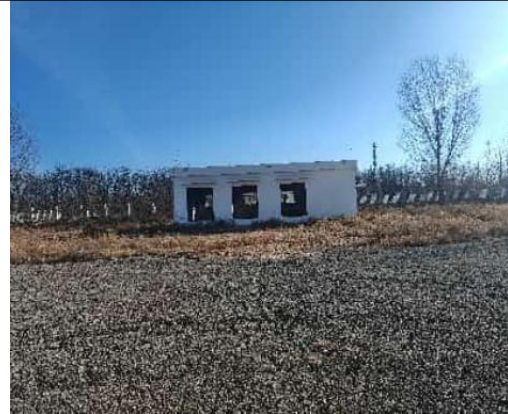
地块东部原场地值班室建筑
