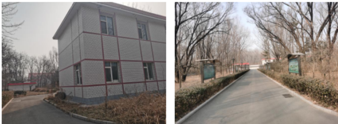
图 4-2 地块内现场踏勘照片（2026 年 1 月 30）
