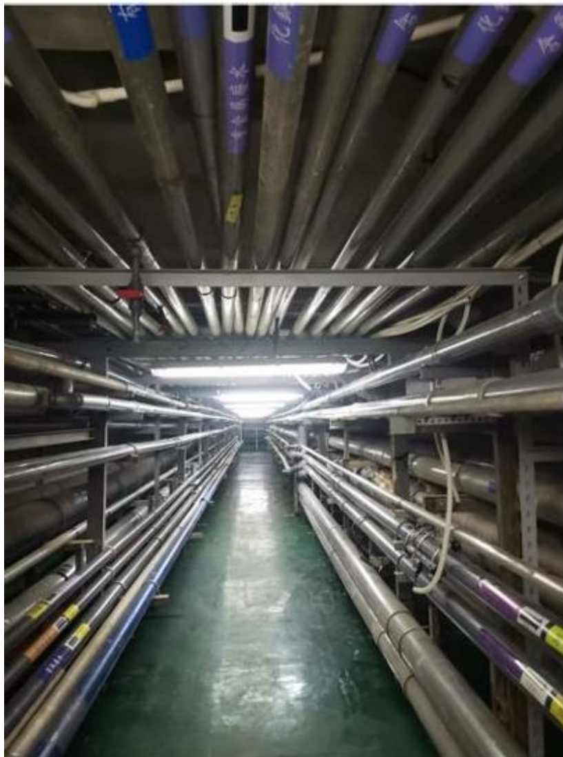
图 4.3-2 污水廊道现场照片
