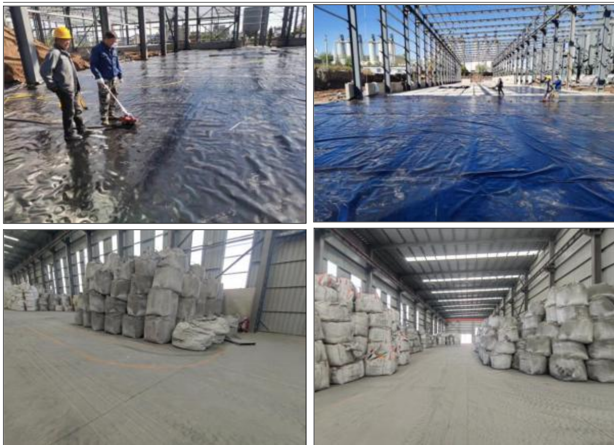
铝灰渣原料库防渗及地面硬化
