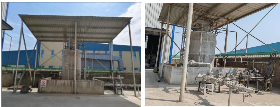
氨水罐区及围堰
