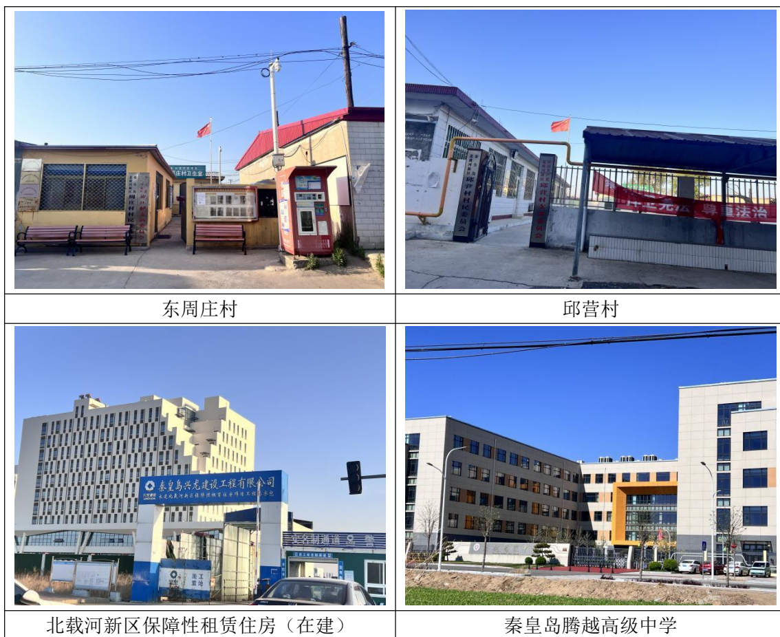
图 3-12 地块周边现状
