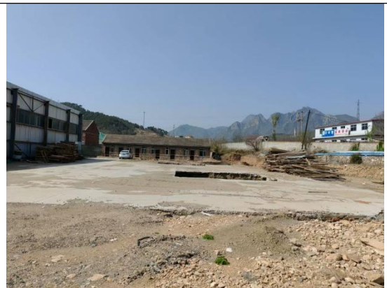
东侧原库房及办公室拆除
