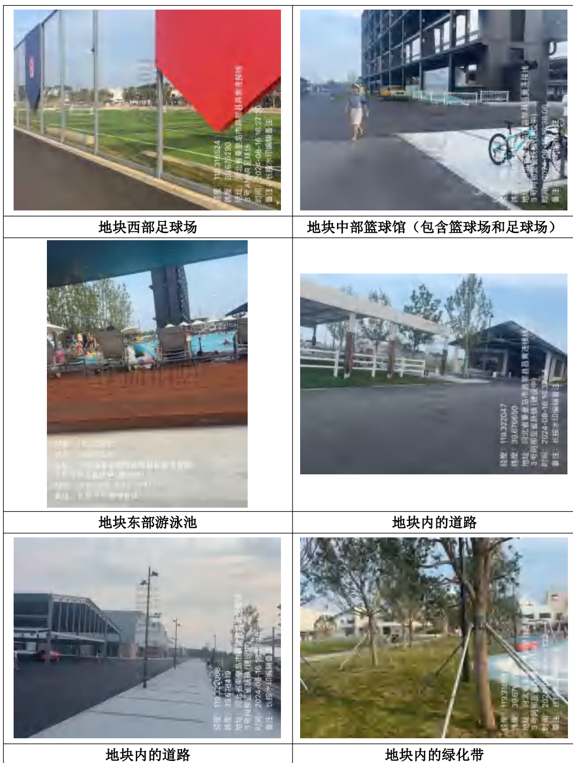
图 4.1-1 现场踏勘情况
