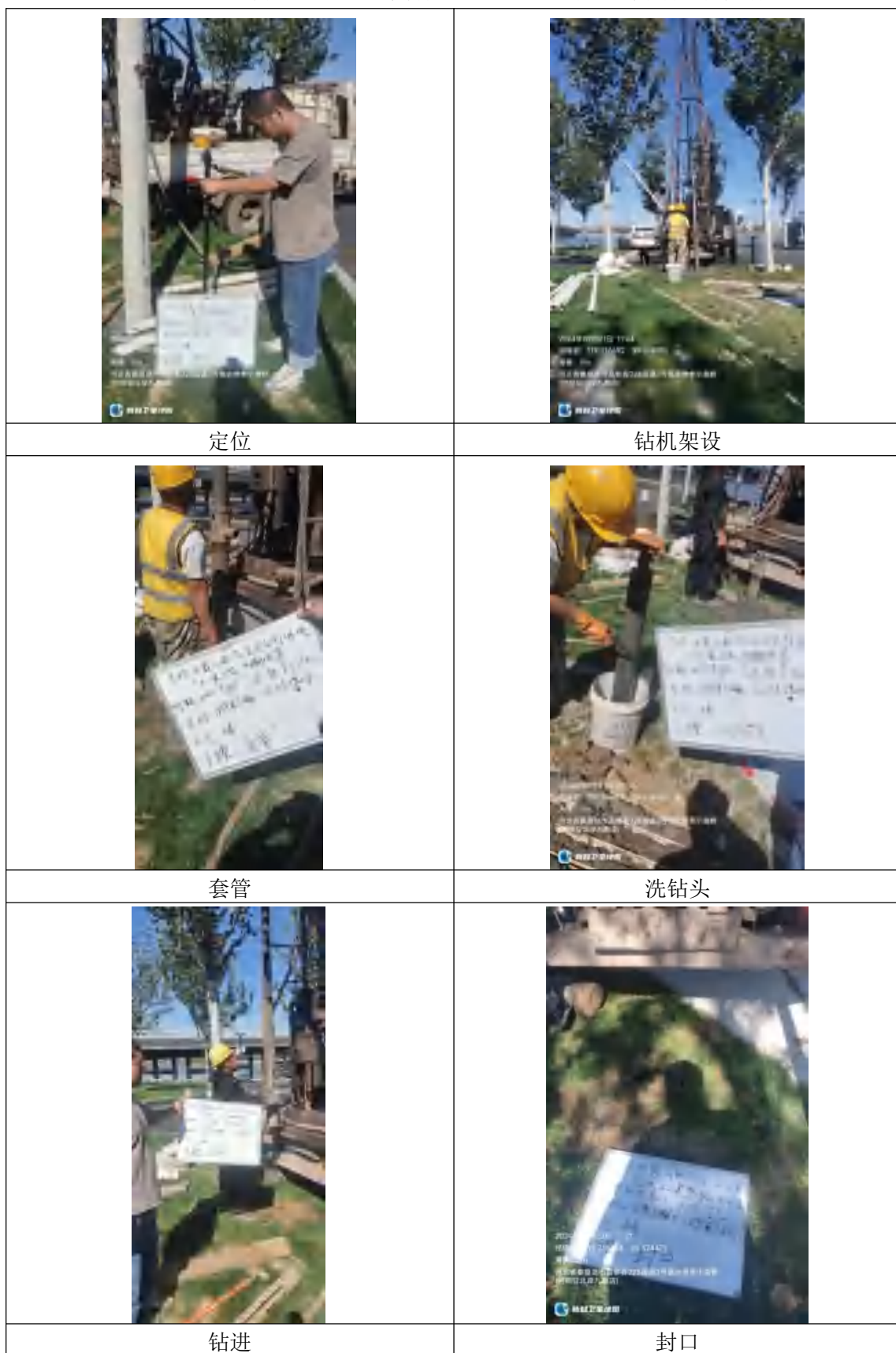
图 6.1-1 现场钻孔图片 (节选)
