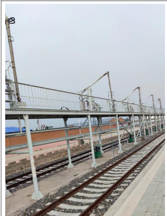
铁路卸车栈桥
