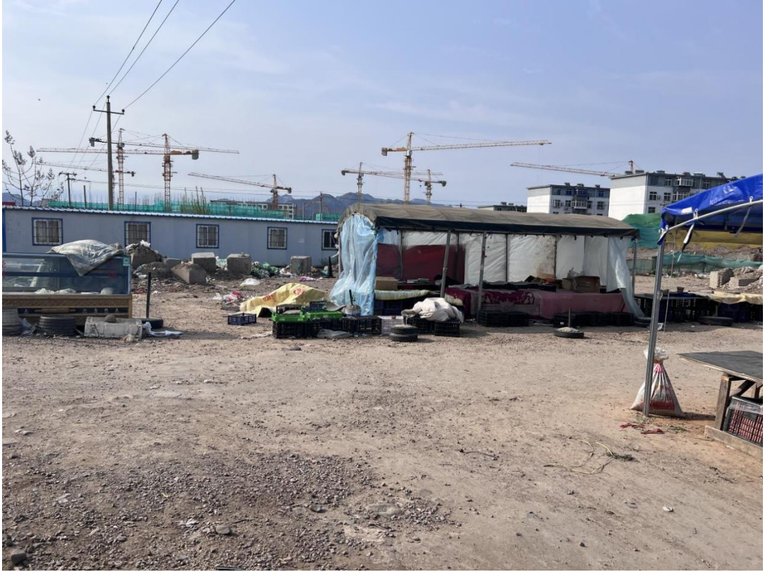
图 3-12 调查地块南侧现场踏勘实况
