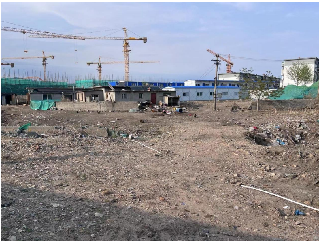
图 3-14 调查地块西北侧残存建筑现场踏勘实况
