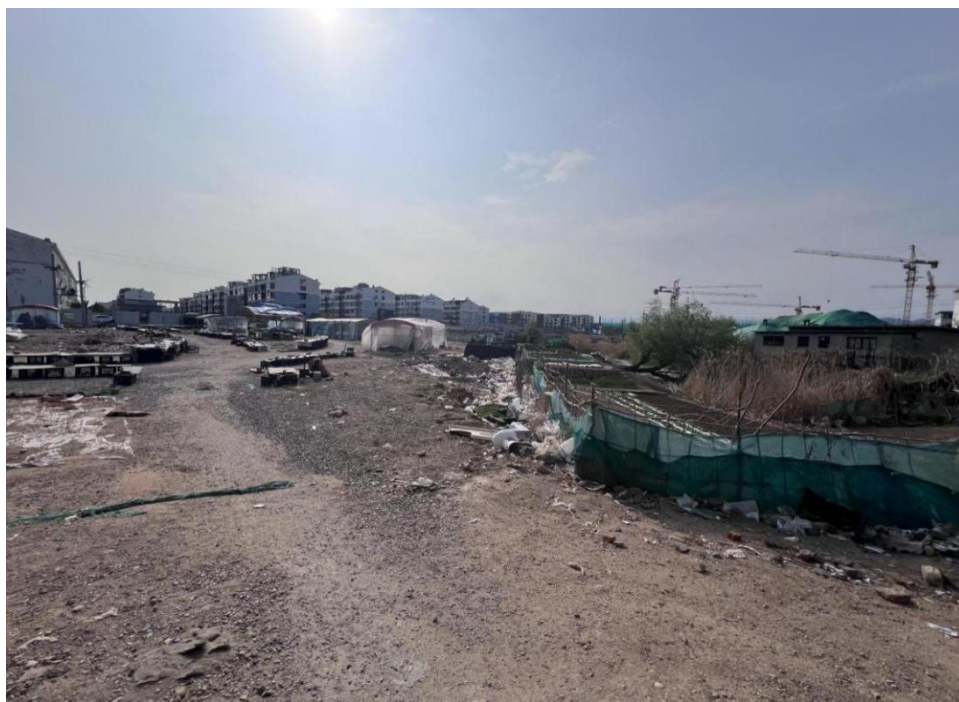
图 3-11 调查地块南侧现场踏勘实况
