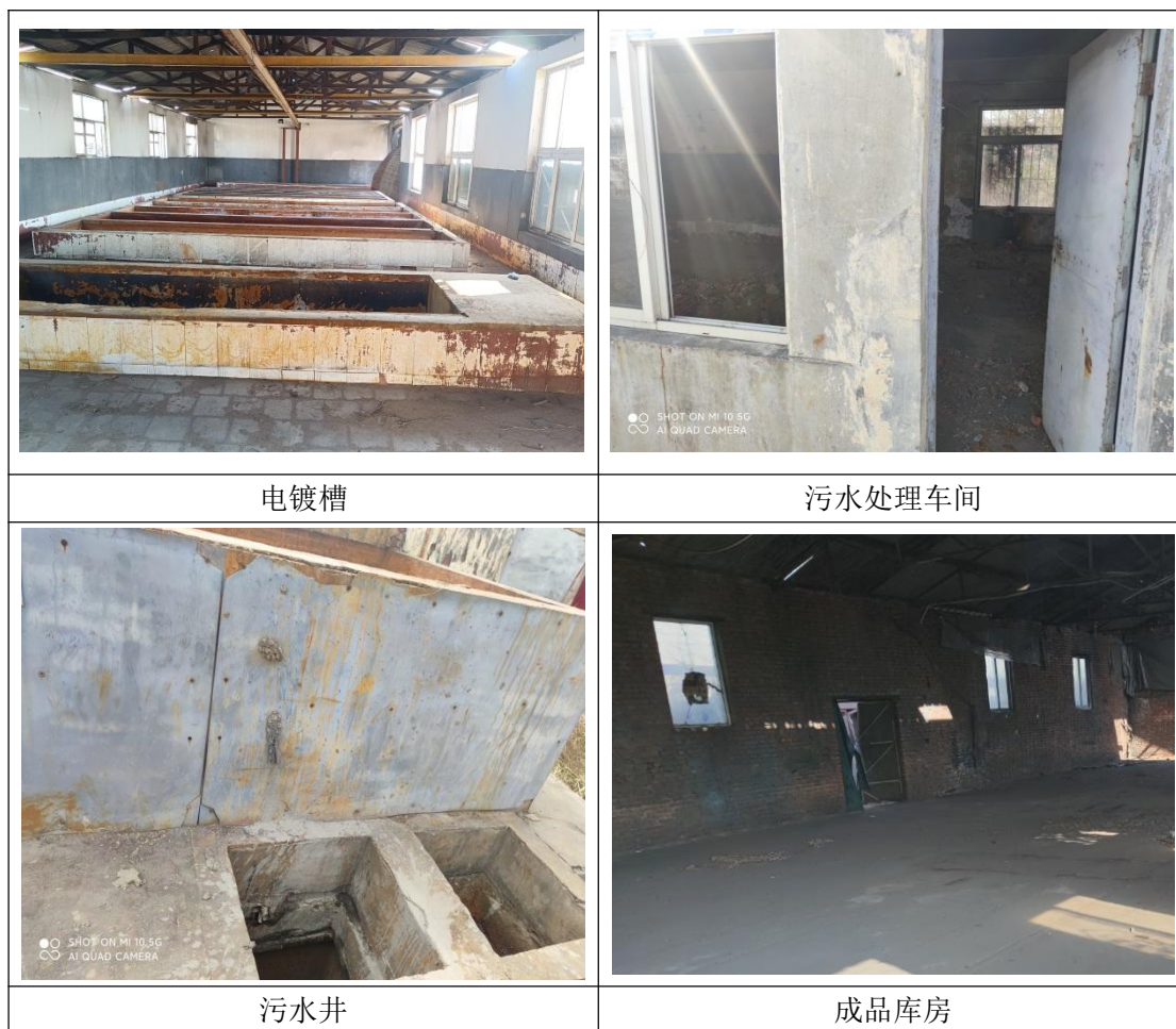
图 2.3-3 初步调查地块内部分现场照片
