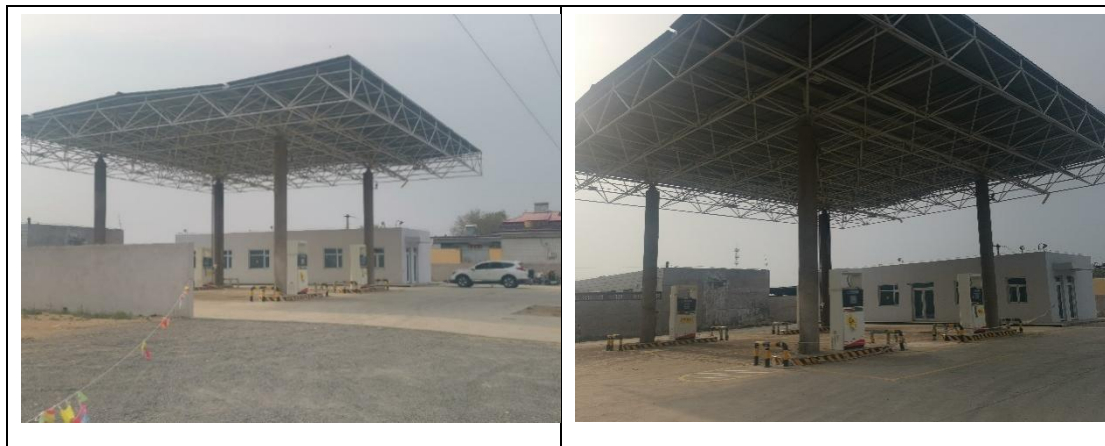
图 5.1-5 加油站现状照片
