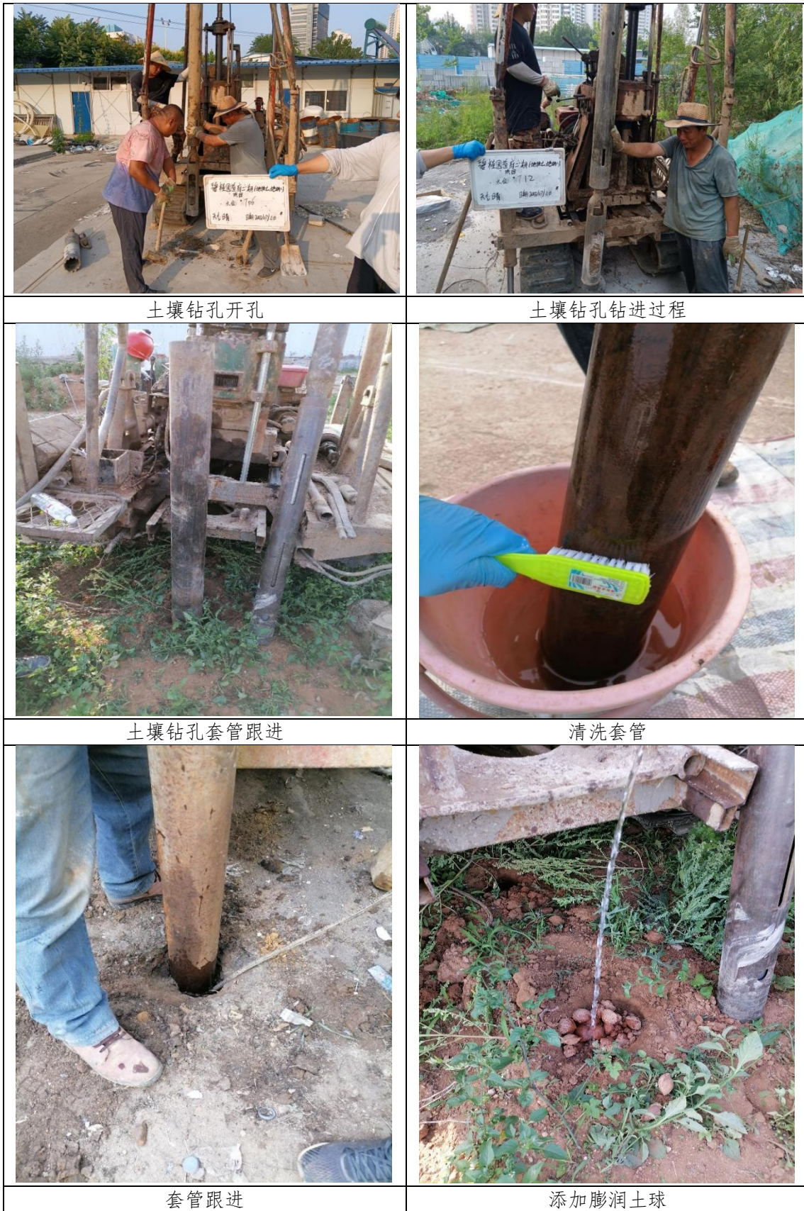
图 6-1 施工现场照片
