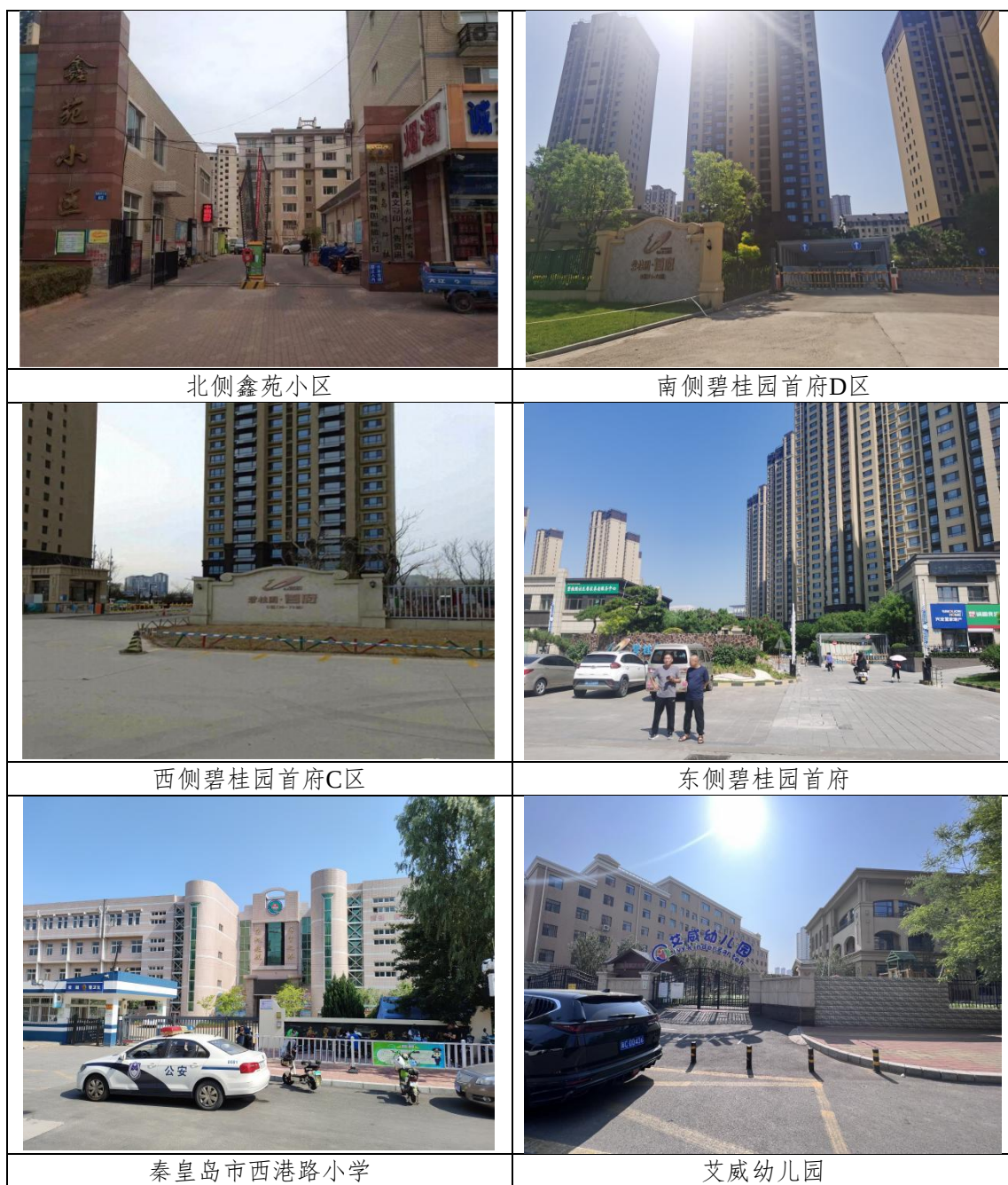
图 4-1 现场踏勘照片
