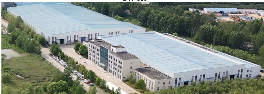
秦皇岛耀华工业技术玻璃有限责任公司项目 地块北侧
