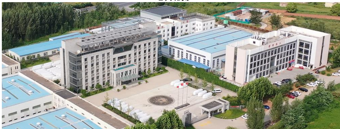
秦皇岛耀华窑炉热态工程有限责任公司项目、兴业公司 地块北侧
