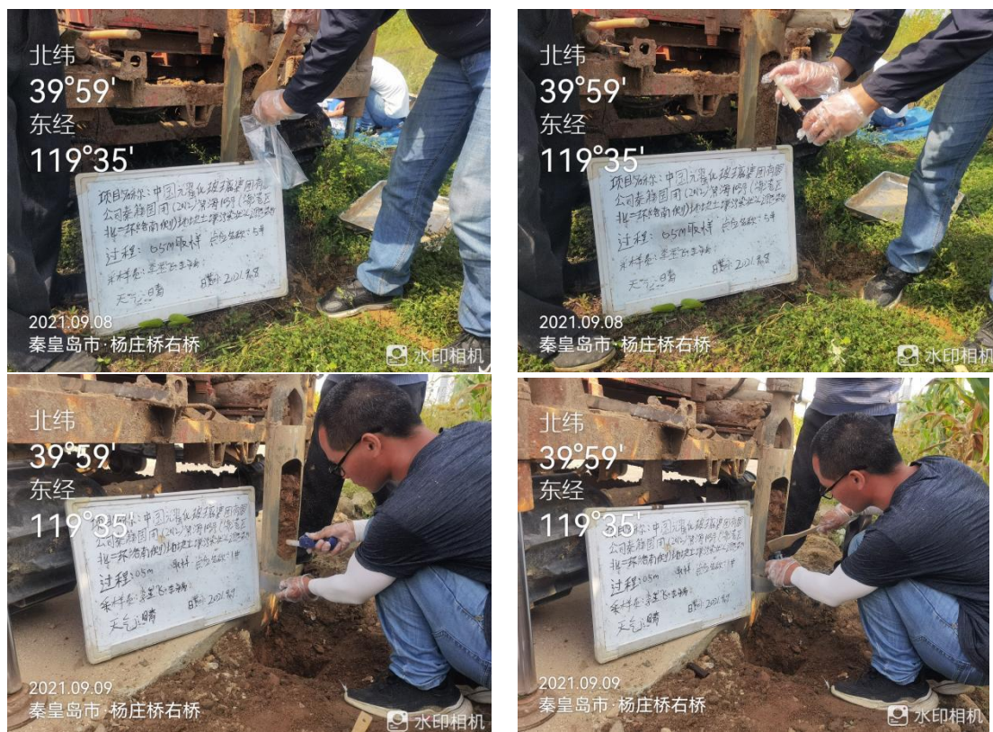
图 5-3 现场钻探情况
