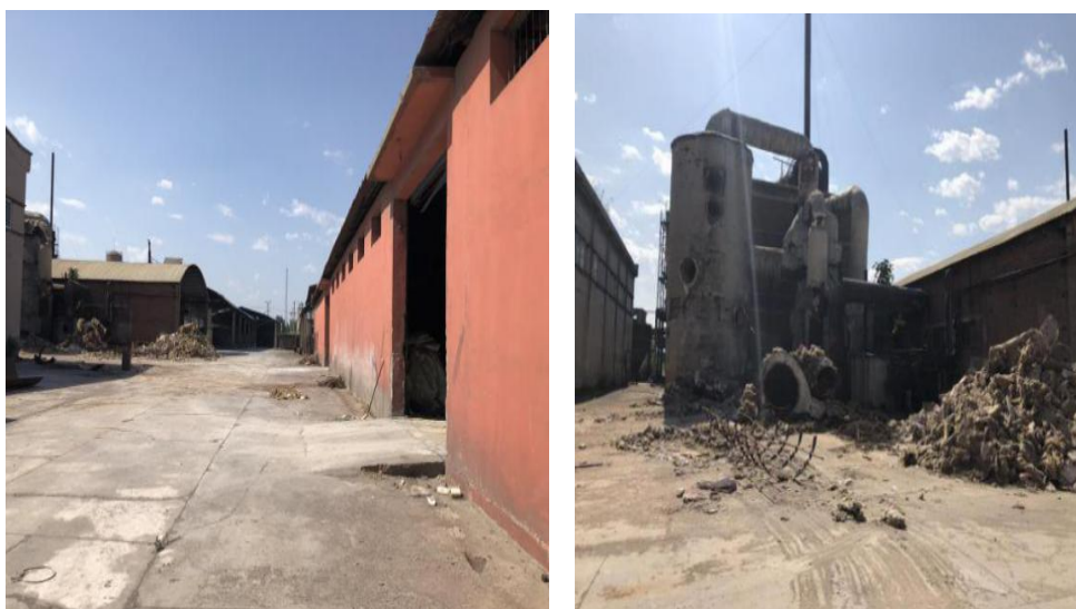
图 2-3 生产设施现状
