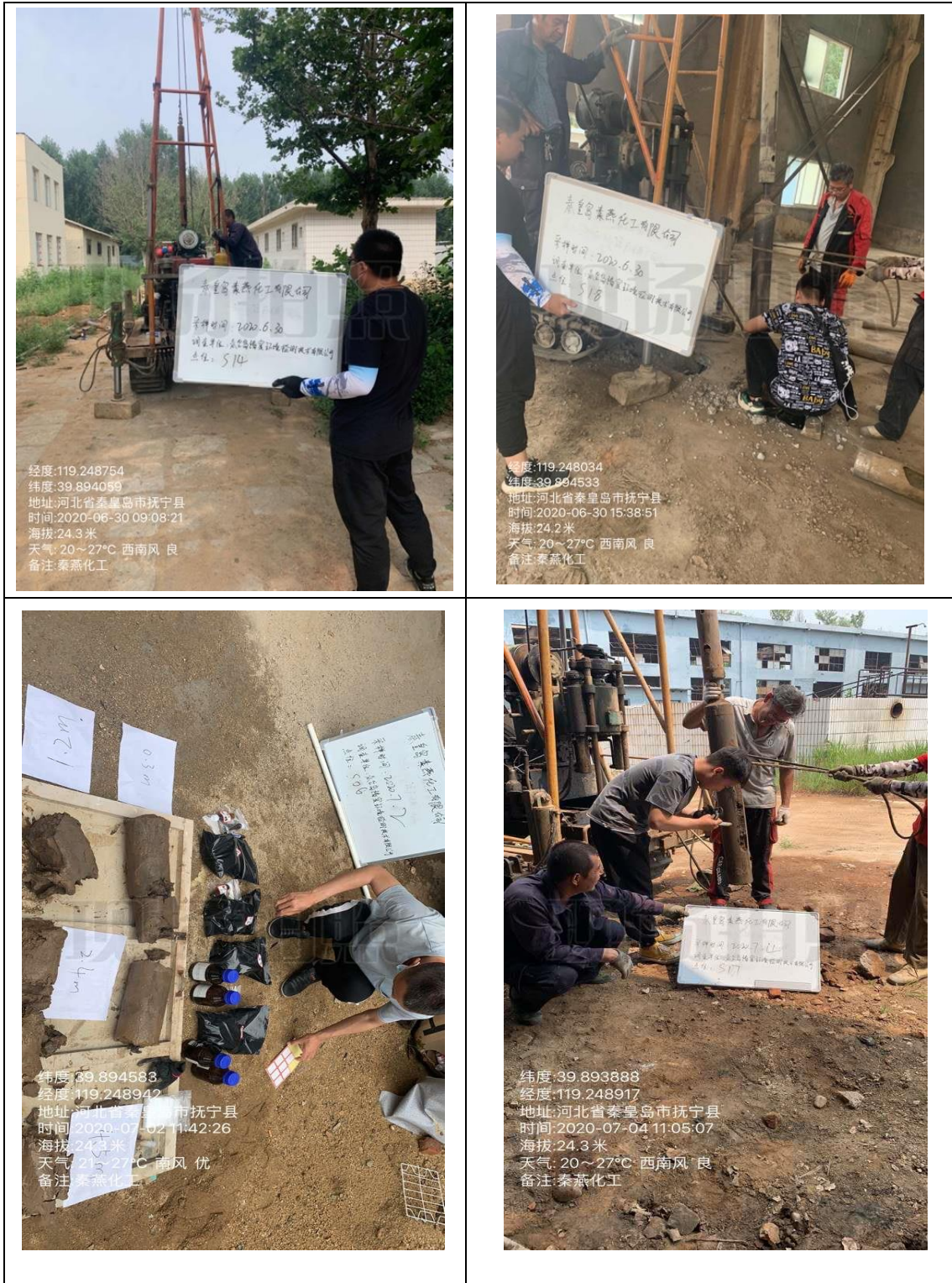
图5.4-1 现场取样情况
