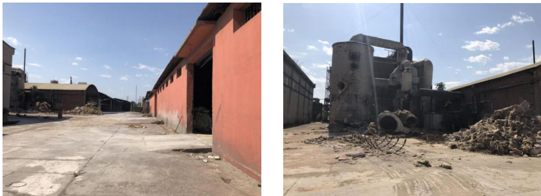
图 2.2-2 现场踏勘情况
