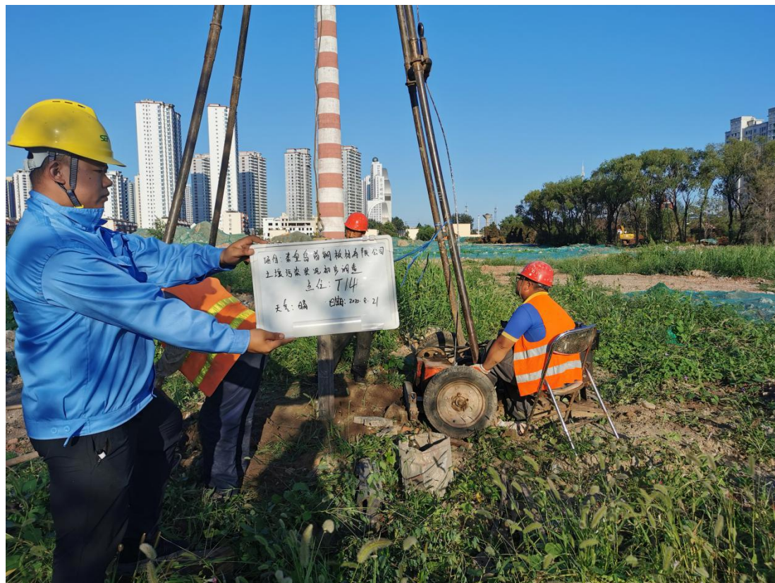
图 5-4 现场钻探情况
