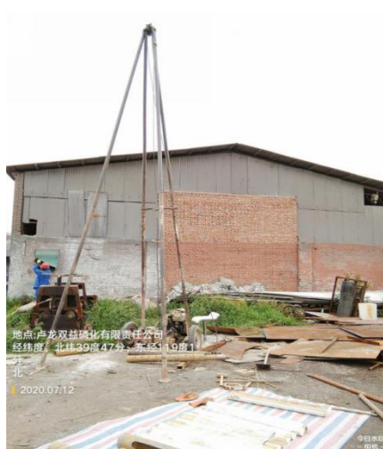
1A02 实际钻孔位置
