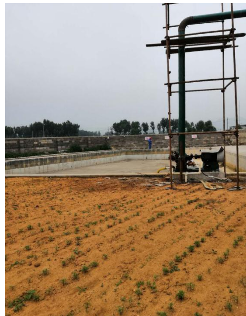
雨水收集池/事故应急池
