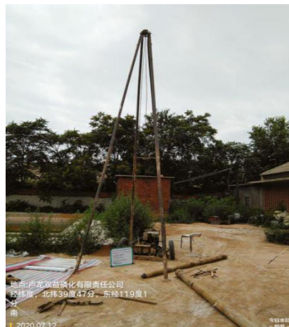
1A01 实际钻孔位置
