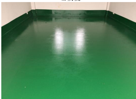
危险废物暂存间
