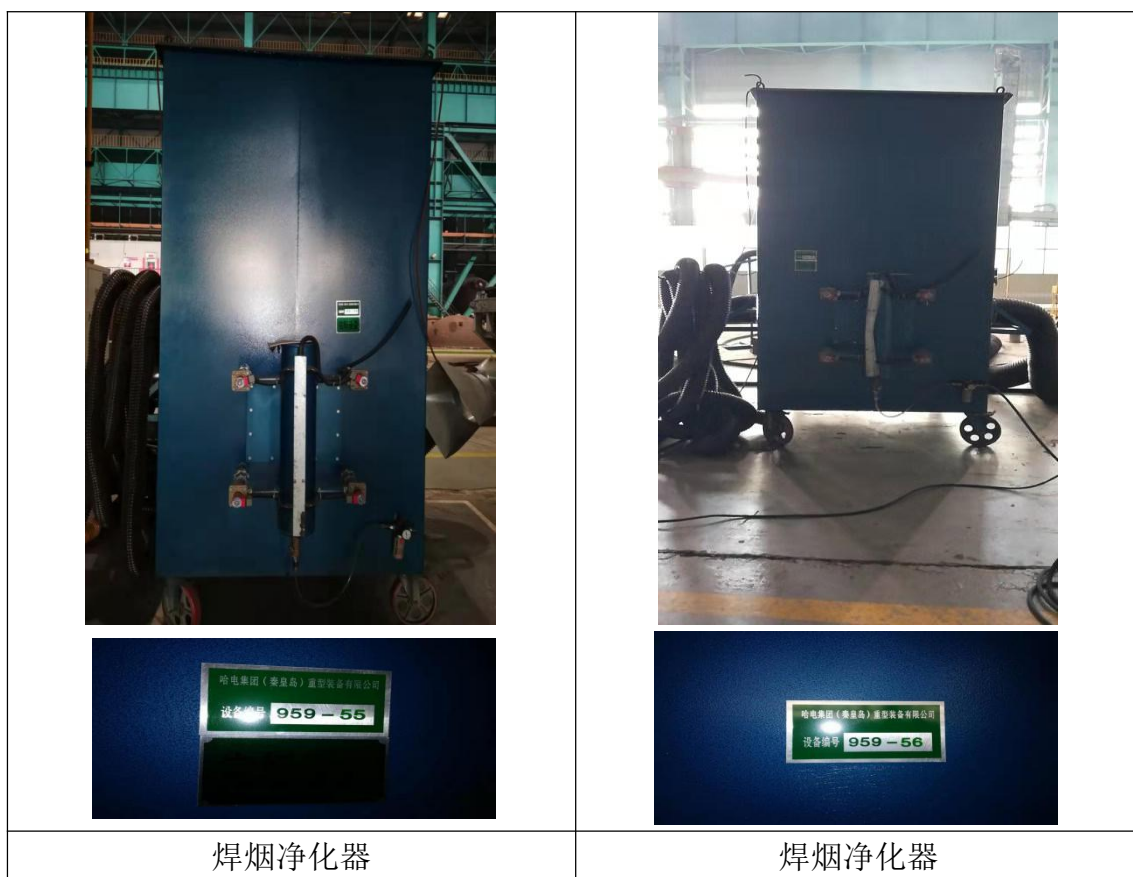
图 4-2 废气治理设施图片
